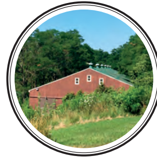
② Arena Barn
